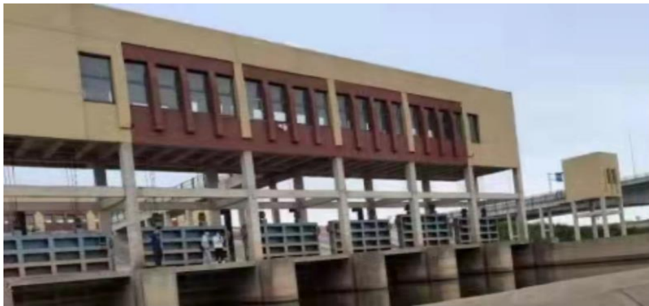
余家山泵站-鼎丰闸“闸站合一”（整治后）
