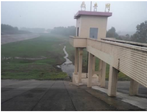
鼎丰闸（整治前）
