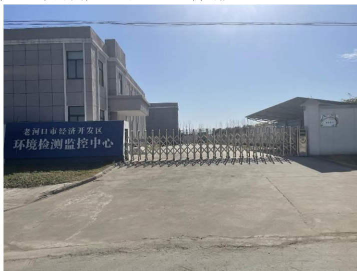
园区环境检测监控中心图片
